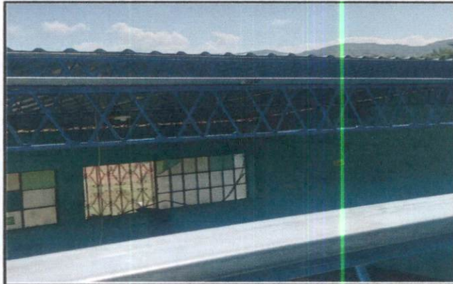
Foto 1: MEJORAMIENTO DE ESTRUCTURA DE TECHO TIPO PORTICO
