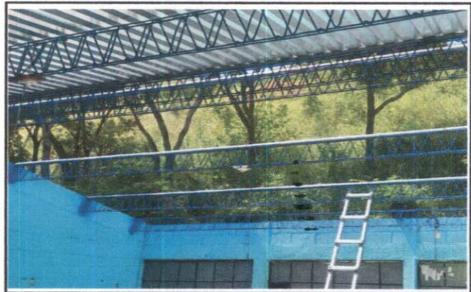
Foto 2: MEJORAMIENTO DE ESTRUCTURA DE TECHO TIPO PORTICO
