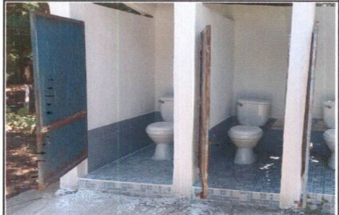
Foto 4: MEJORAMIENTO DE SERVICIOS SANITARIOS Y SUS ACCESORIOS
